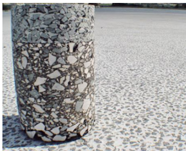
Рисунок 1. Асфальтоцементобетон (вид готового покрытия)
