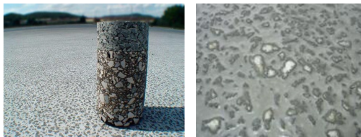
Рисунок 4. Вид готового асфальтоцементобетонного покрытия
