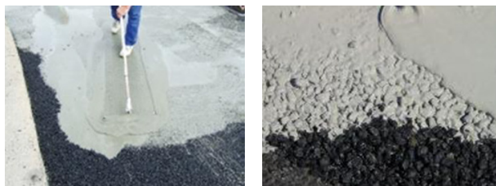
Рисунок 3. Пропитка асфальтобетона цементным раствором
